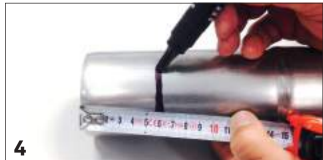
4 Marcatura quota d'innesto / Marking the insertion's depth
